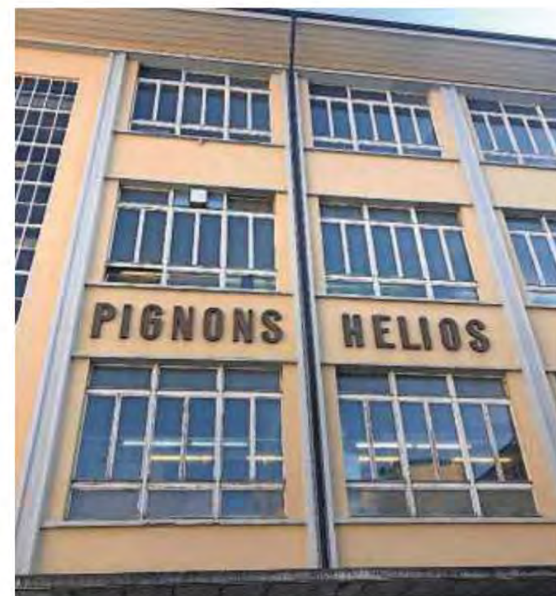
L'entreprise Helios s'en ira à Court, où elle construira de nouveaux locaux.
